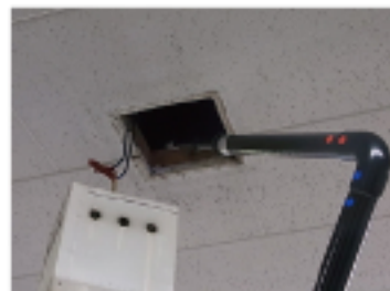
ダウンライトの穴を利用して、通線作業をしているところ
