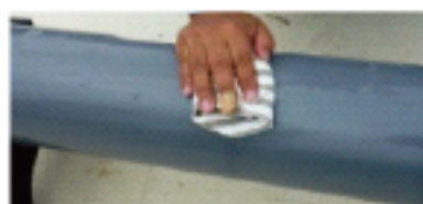
写真-1 管の清掃
